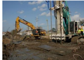
Boden (Untersuchung und Sanierung)
